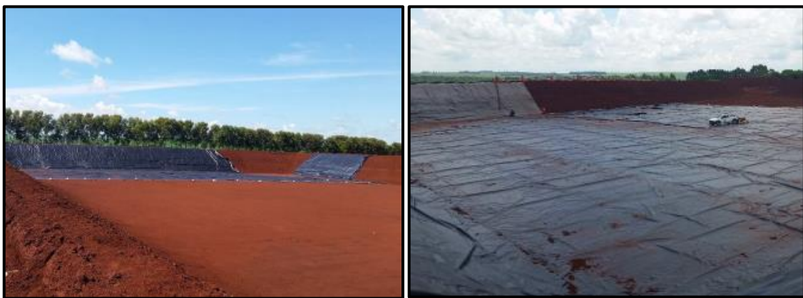
Figura 19 – Exemplo de impermeabilização da célula com manta PEAD.
