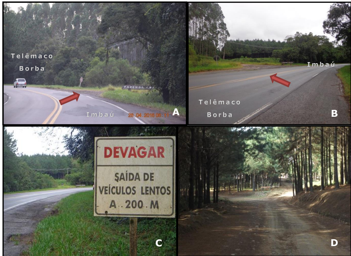
Figura 8 – Intersecção entre a PR-160 (A e B), sinalização (C) e via secundária de acesso (D).
