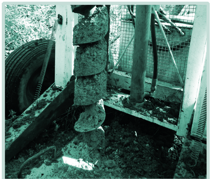
Execução de sondagem para avaliação do solo e do nível do lençol freático.
