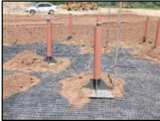
Figura 37 - Modelo de placa de recalque que poderá ser utilizada para o monitoramento geotécnico do aterro.
